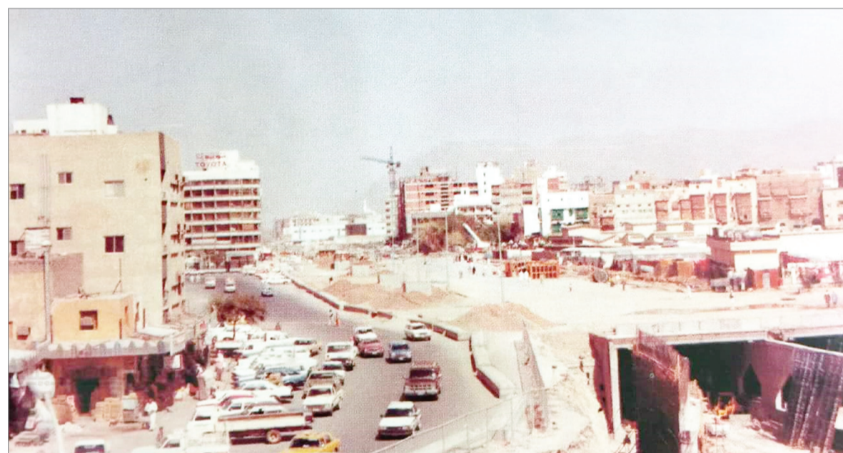
أثناء انشاء نفق المناخة في الثمانينيات الميلادية
