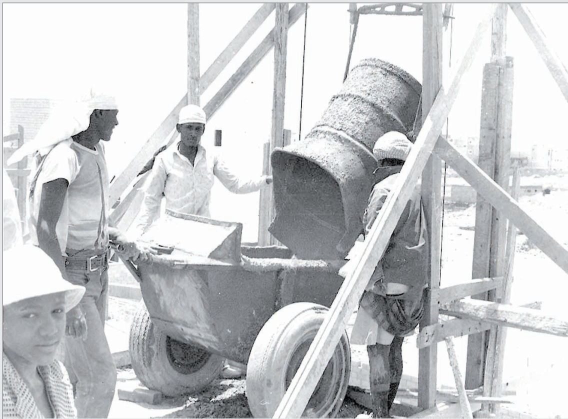
أعمال البناء بالطريقة التقليدية القديمة
