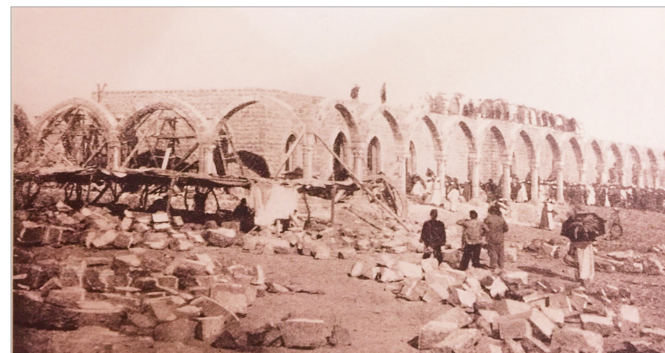
صورة أثناء بناء محطة الاستسيون بالعنبرية ويظهر في الصورة حجارة البناء الذي في أواخر عهد السلطان عبد الحميد الثاني
