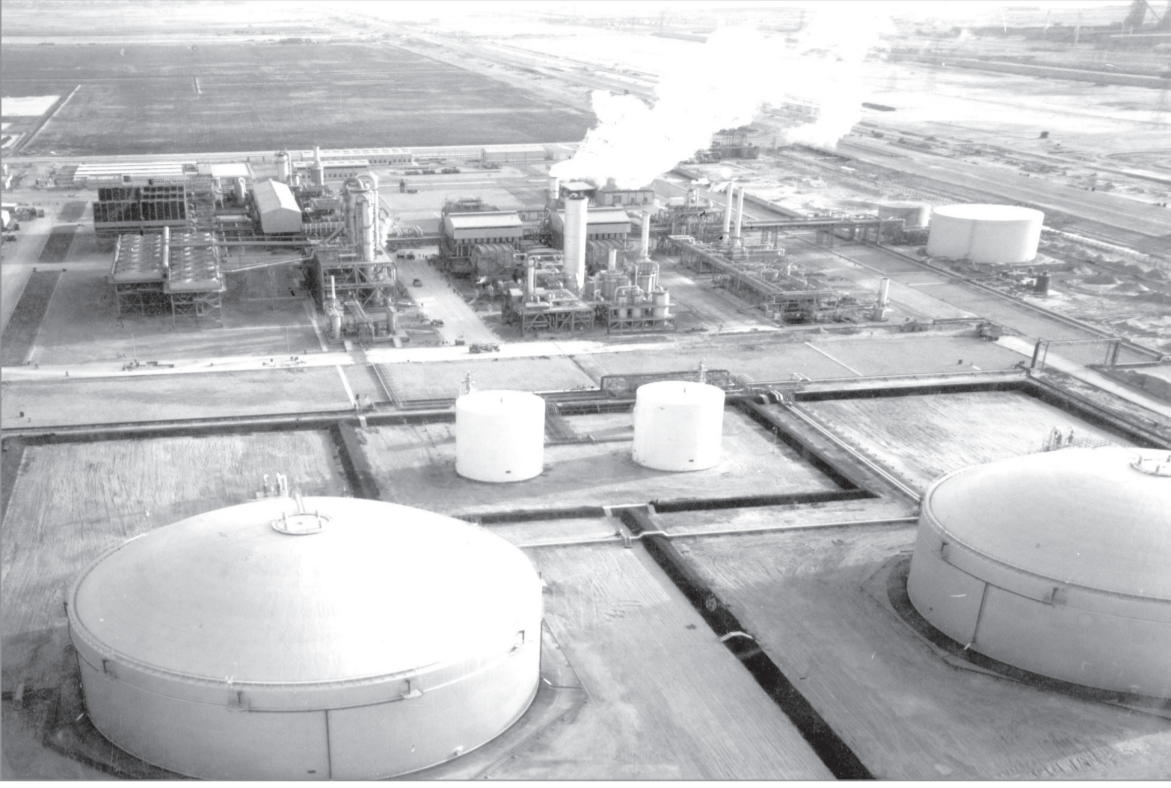
الشركة السعودية للميثانول (الرازي) أول مصنع يتم بناؤه في مدينة الجبيل الصناعية
