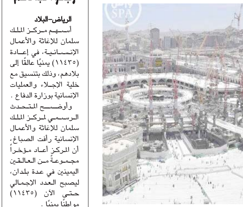
قامت الرئاسة العامة لشؤون المسجد الحرام والمسجد النبوي بتشغيل جسر أجياد الواقع جنوب مبنى توسعة الطائف الذي تم إعادة ربطه بالدور الأول من المرحلة الثالثة لمشروع توسعة الطائف بعد استكمال أعمال تهيئة الجسر بشكل مؤقت . وأوضح مدير عام إدارة المشاريع بالرئاسة العامة لشؤون المسجد الحرام والمسجد النبوي المهندس سلطان بن عايطي القرشي، أن الجسر يبلغ طوله ٨٨ متراً وعرضه ١٢ متراً، مفيداً أن أهمية هذا الجسر تتمثل في نقل الحشود من الساحات إلى الدور الأول مباشرة والعكس وذلك لتخفيف الزحام على أبواب الدور الأرضي للمسجد الحرام حيث باشرت الجهات الخدمية والأمنية لإدارة حركة الحشود على جسر أجياد .
