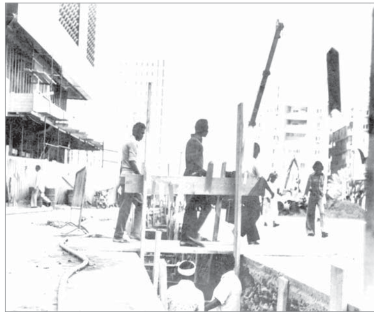
تمديد شبكات الكهرباء
